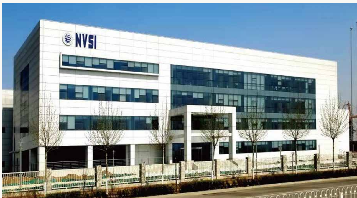
北京国家疫苗中心, 办公楼, 2010年 Beijing National Vaccine Center, Office Building, 2010
