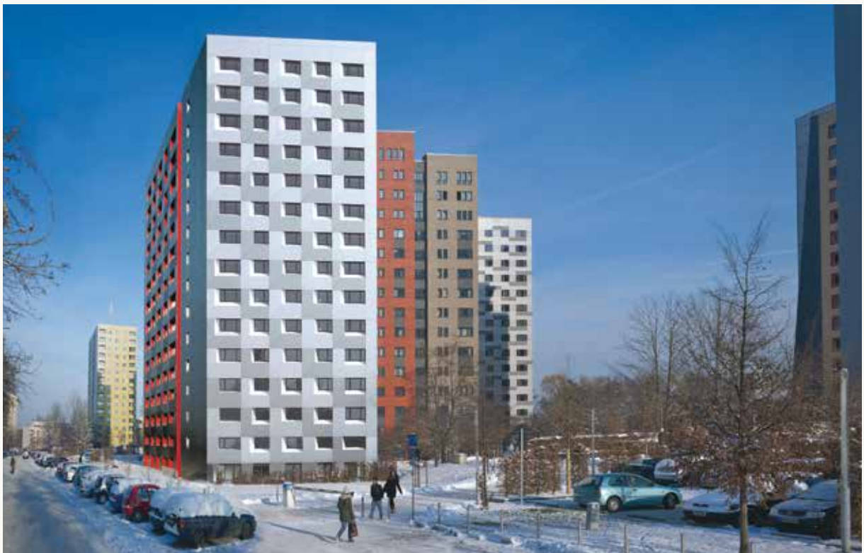
德国德累斯顿学生公寓, 住宅项目, 2009年 Student Residence, Dresden, Residential Project, 2009
