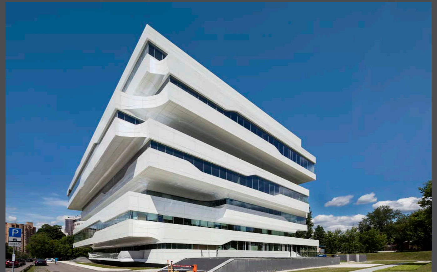
Vertically stacked plates are connected by curved elements. Vertikal aufeinander gestapelte Ebenen erhalten durch runde Elemente ihre Verbindung.
