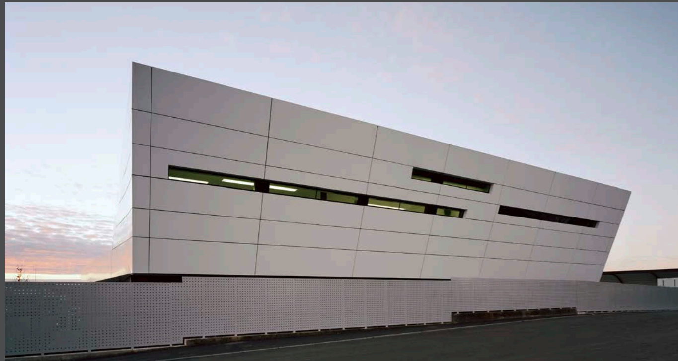
High efficiency technology teamed with intelligent building design. Hocheffiziente Technik kombiniert mit einer intelligenten Gebäudegestaltung.
