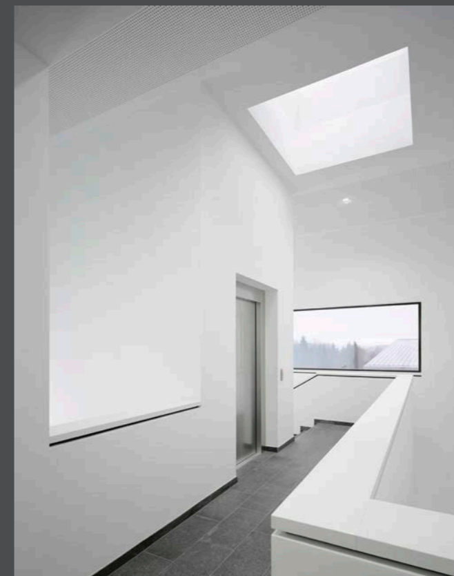
Light shafts in the upper storey allow additional natural daylight. Lichthöfe im Obergeschoss lassen zusätzliches Licht in die Bürobereiche.
