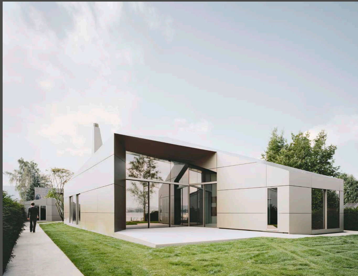
The dark joints of the large-format tray panels cover the whole building in a grid format. Die dunklen Fugen der großformatigen Kassetten überziehen den gesamten Baukörper mit einem Raster.
