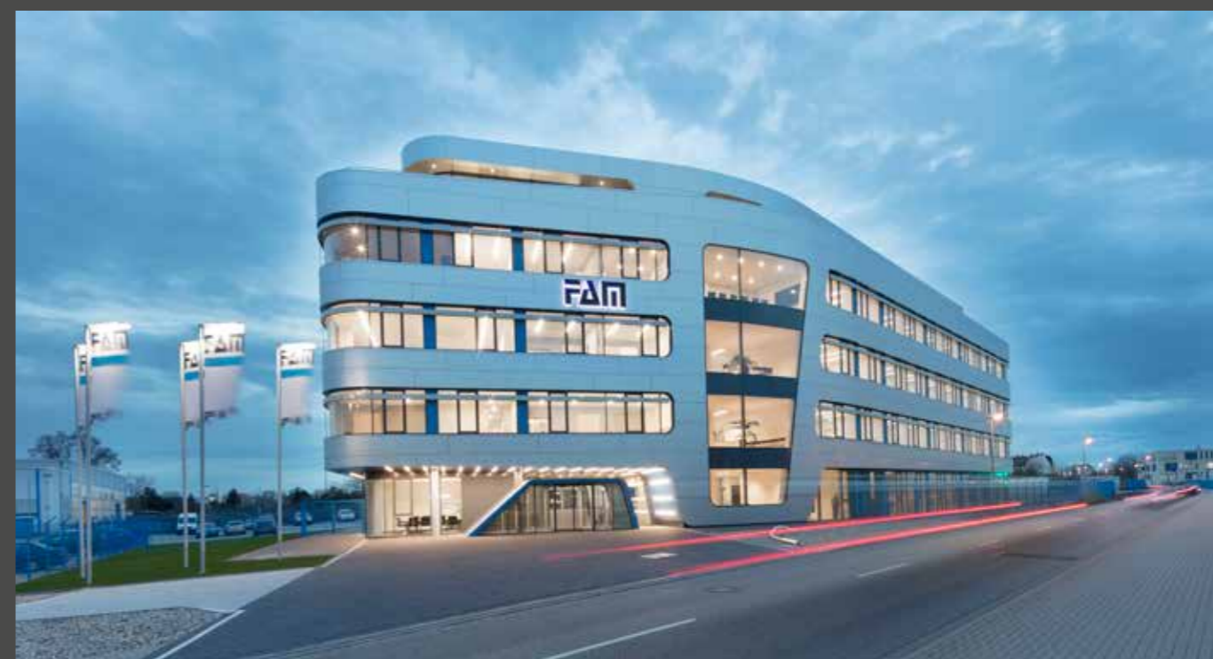
Large format panels in conjunction with a curved geometry create the modern appearance of the structure. Großformatige Platten lassen gemeinsam mit den Rundungen ein futuristisches Bild entstehen.
