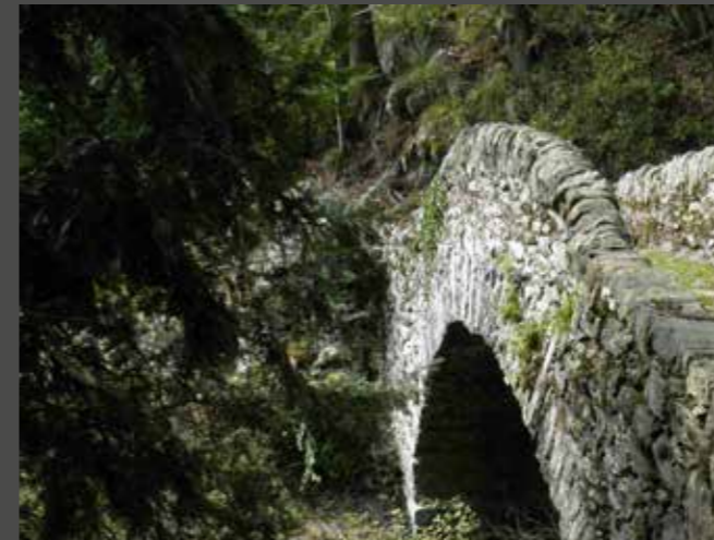
Roman Bridge | Römische Brücke
