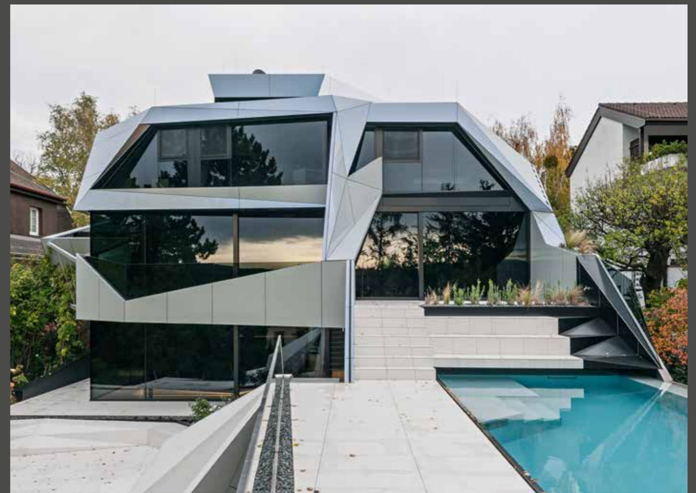
Panels cut to form acute angles and structures tapering off to nothing attest the excellence. Spitzkantige Plattenzuschnitte und auf Null auslaufende Aufbauten zeugen von hoher Qualität.
