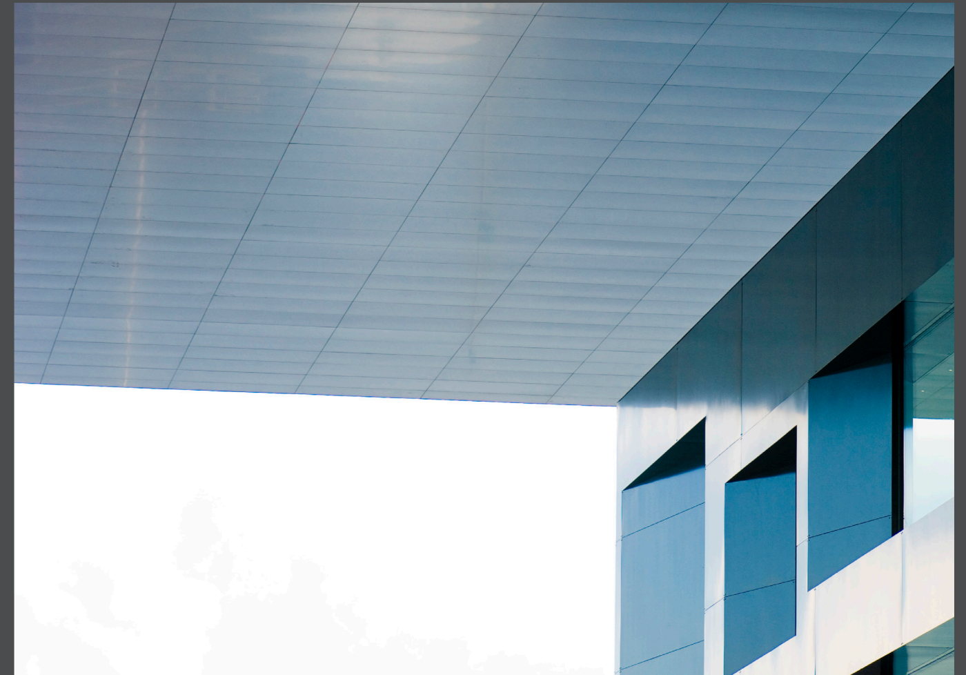
The joints only have a width of 4-6 mm. Die Fugen haben lediglich eine Breite von 4-6 mm.
