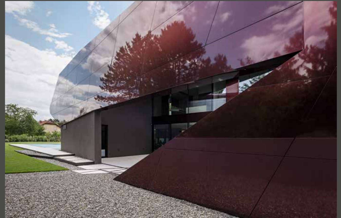
The inner glass façade provides a clear view and plenty of natural light. The outer concrete envelope ensures secluded outdoor living. Die innere Glasfassade bietet freie Sicht und viel Licht. Die äußere Betonhülle ermöglicht sichtgeschütztes Wohnen auch im Freien.
