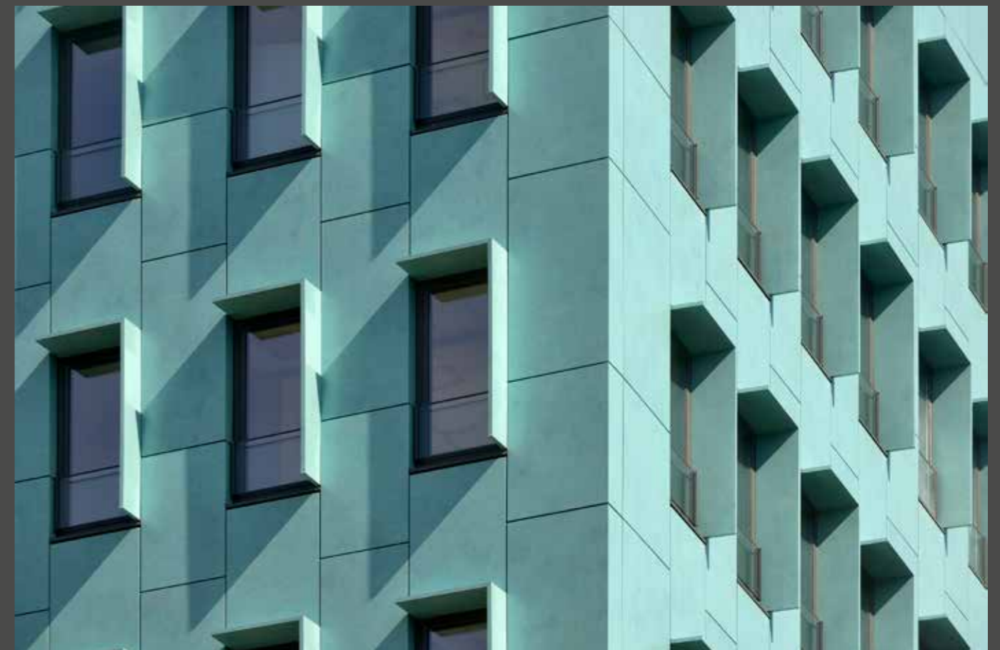
Projections and indentations in the façade break the large volume up and convey a more appropriate scale. Vor- und Rücksprünge gliedern die Fassade auf und geben der eigentlichen Großform einen angemesseneren Maßstab.
