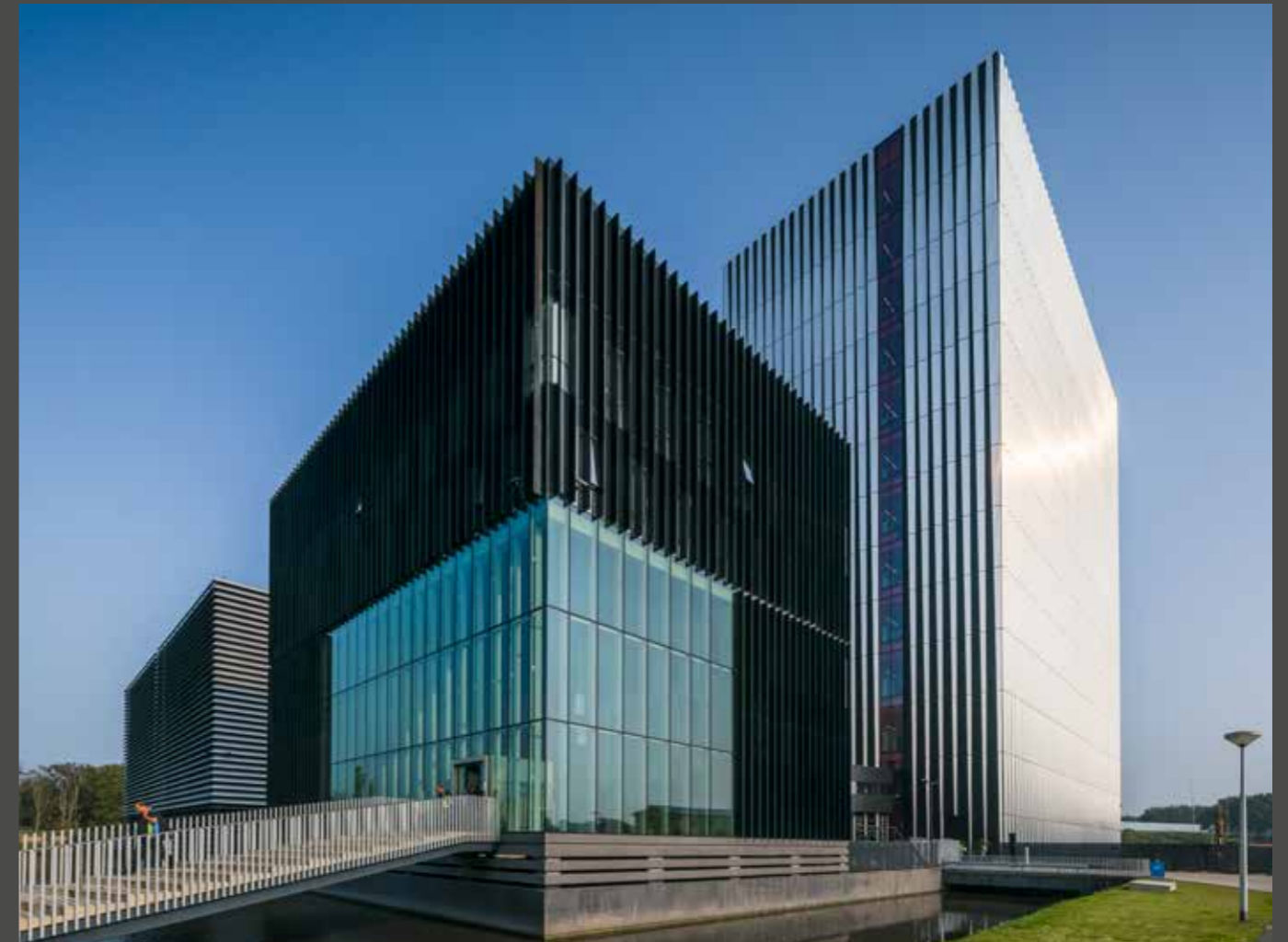
The AM4 data centre is part of a building complex comprising an entrance building and another data centre. Das AM4-Rechenzentrum ist Teil eines Gebäudeensembles mit Eingangsgebäude und einem weiteren Datenzentrum.
