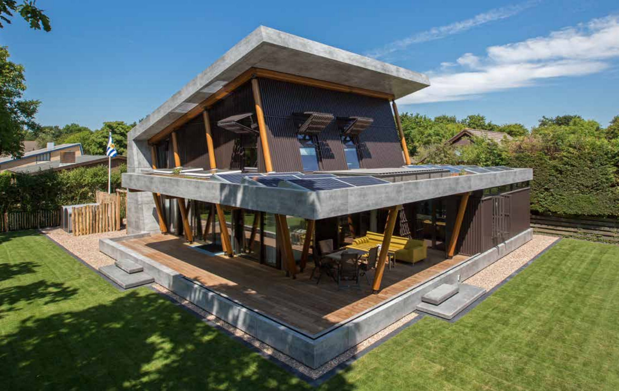
Can such slender, tilted timbers support so much concrete? Impossible in terms of building physics but possible visually, thanks to a wood-steel construction with ALUCOBOND® panels in Vintage Concrete, but keep that to yourself. | So dünne, geneigte Holzstützen tragen so viel Beton? Das statisch Unmögliche ist optisch möglich, dank einer Holz-Stahlkonstruktion mit ALUCOBOND®-Platten in Vintage Concrete, aber pssst...
