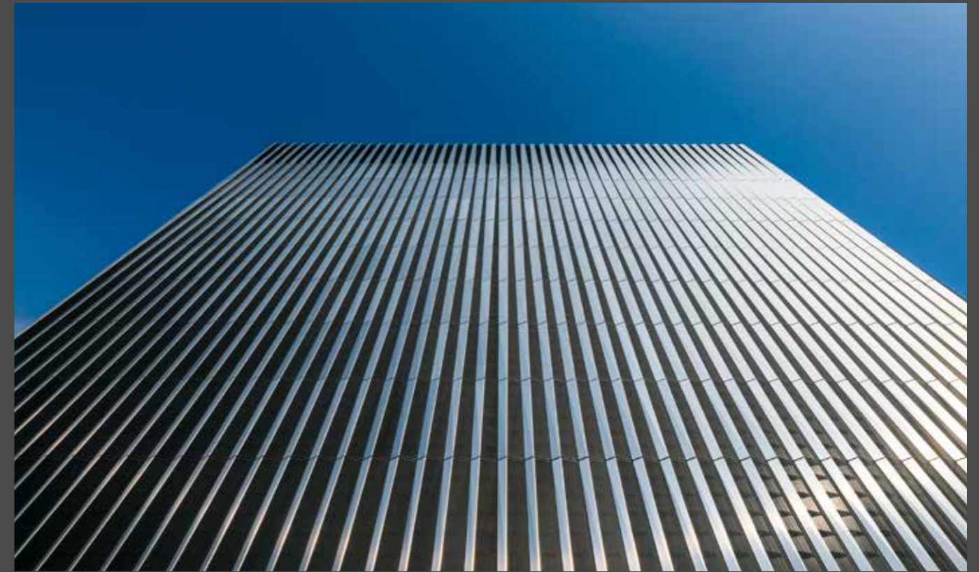
The fold lines in the ALUCOBOND® façade change and create an optical illusion. How high is higher? Die gefaltete ALUCOBOND®-Fassade verändert ihren Falzverlauf und erzeugt so eine optische Täuschung. Wie hoch ist höher?
