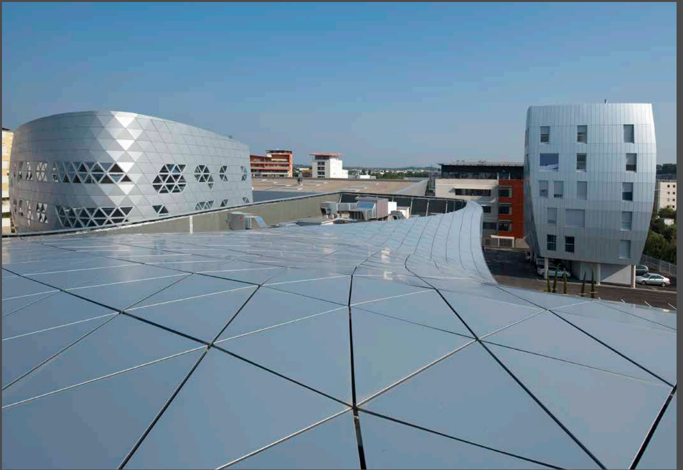
The façade grid extends over parts of the roof. In this case, the curved surface is not made of reinforced concrete but a lightweight metal supporting structure. Photos: Moreno Maggi, Rome | Das Fassadenraster zieht sich auch über Teile des Daches. Die gebogene Fläche formt hier allerdings nicht eine Stahlbetondecke, sondern eine leichte Unterkonstruktion aus Metall, die auf das Dach gesetzt ist.
