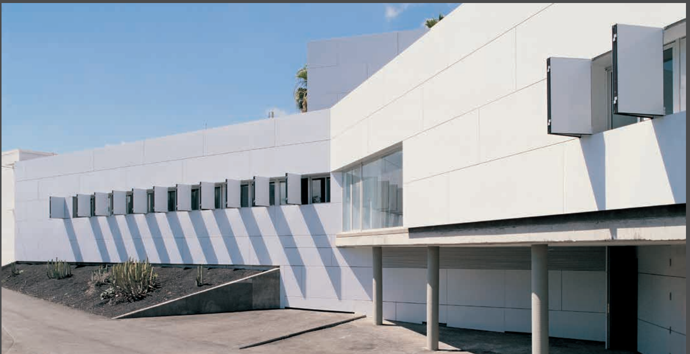
On the south façade ALUCOBOND® tray panels act as window shutters offering protection from the sun, on the east façade they guide the sunlight into the interior space. Photos: José Ramón Oller, Tenerife | Auf der Südfassade schützen die ALUCOBOND®-Kassetten als Fensterläden vor der Sonne, auf der Ostfassade lenken sie das Tageslicht weit in die Innenräume.
