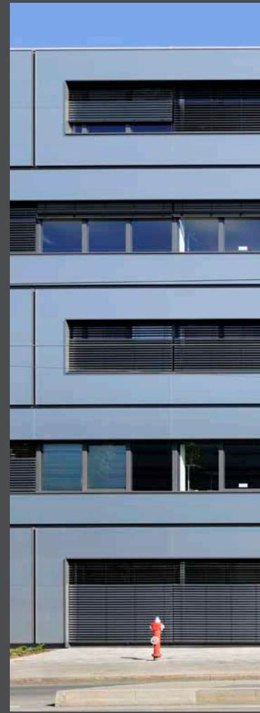
Thanks to the frame construction, the extra-long band elements on the elevation and building's edges provide interesting façade contours and panorama format views. Photos: Ralf Dieter Bischoff, Nuremberg | Auch dank der Skelettbauweise bewirken die überlangen Bandmodule in der Ansicht und in der Gebäudekante ein interessantes Fassadenrelief und Ausblicke im Panoramaformat.
