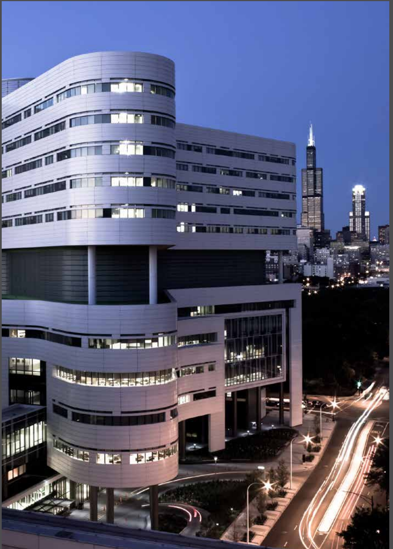
The iconic shape results from the desire for better quality spaces: the maximum number of rooms with ample daylight and designed to minimize distances. All photos: R. R. Gigliotti, Chicago | Die ikonographische Figur resultiert aus dem Wunsch nach besseren Raumqualitäten: maximal viele Räume mit viel Tageslicht zu versorgen und über kurze Wege zu verbinden.
