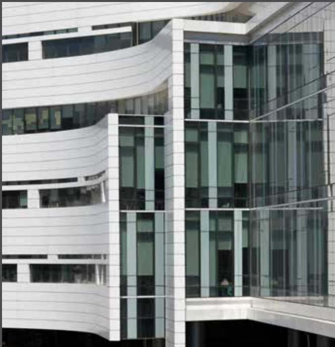
Almost 25000 m 2 of ALUCOBOND® panels were produced and installed to create Rush-Hospitals curvilinear shape. All photos: R. R. Gigliotti, Chicago | Für die kurvige Kubatur des Rush-Hospitals wurden fast 25.000 m 2 ALUCOBOND®-Tafeln mit CAD passgenau produziert und montiert.
