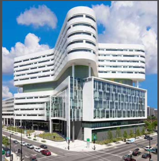
Almost 25000 m 2 of ALUCOBOND® panels were produced and installed to create Rush-Hospitals curvilinear shape. All photos: R. R. Gigliotti, Chicago | Für die kurvige Kubatur des Rush-Hospitals wurden fast 25.000 m 2 ALUCOBOND®-Tafeln mit CAD passgenau produziert und montiert.
