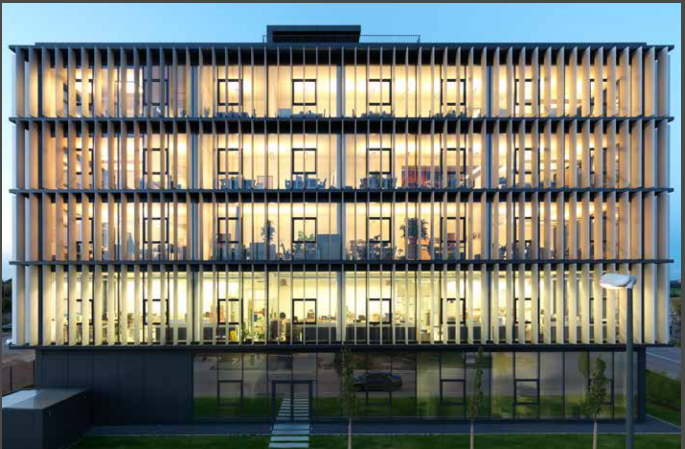
The floor-high aluminium sun protection slats give the multi-layered façade structure and rhythm. | Die geschosshohen Aluminium-Sonnenschutzflügel strukturieren und deklarieren die mehrschichtige Gebäudehülle.
