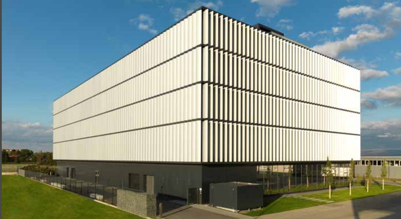
2500 m 2 of ALUCOBOND® panels envelop the building. All photos: Richie Müller, Munich | 2.500 m 2 ALUCOBOND®-Platten umhüllen das Gebäude.
