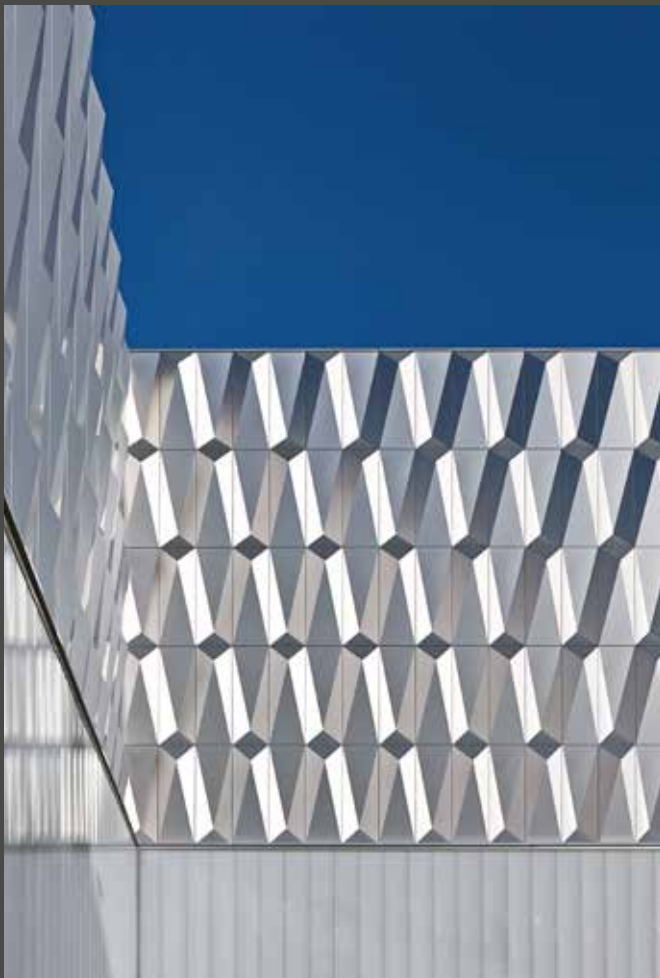
The three-dimensional façade refracts light. Die plastische Fassadenbekleidung reflektiert das Licht.
