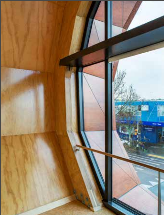
The laminated veneered lumber components combine with the outer skin made of ALUCOBOND®. Die Bauteile aus furniertem Holz harmonieren mit der Außenhülle aus ALUCOBOND®.
