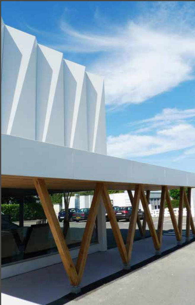
The façade appears to be poised on top of wooden supports. Die Fassade scheint von Holzpfählen getragen zu werden.
