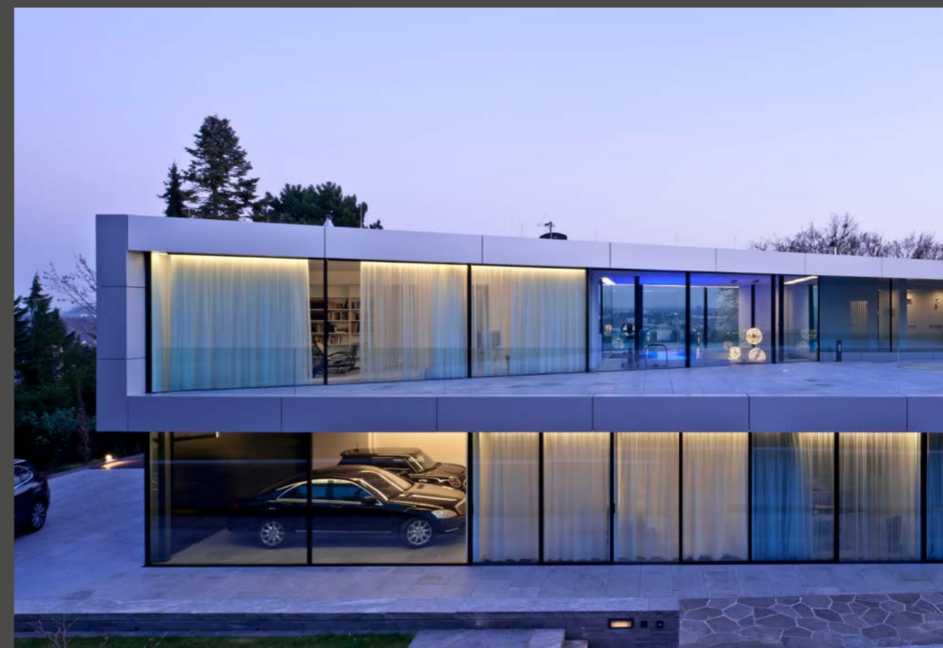
The envelope reflects the light as it changes throughout the day and the façade translates the rays into a special metallic glow. Die Gebäudehülle reflektiert die im Tagesverlauf variierenden Lichtverhältnisse und interpretiert sie mit einem eigenen, metallischen Glanz.
