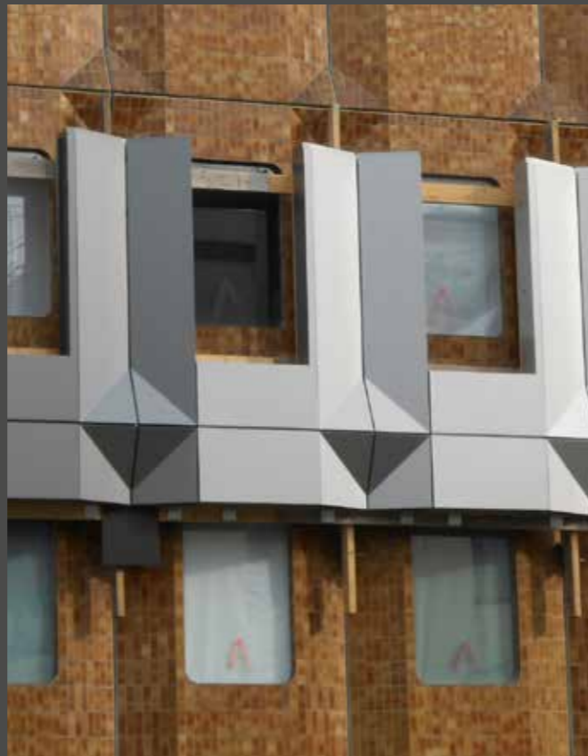
A second skin of prefabricated elements | Eine zweite Haut aus vorgefertigten Modulen
