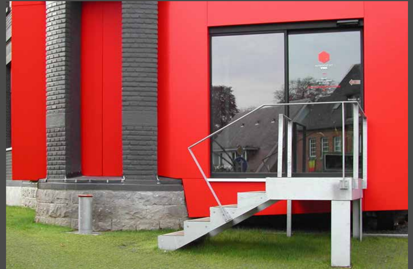
The cuboid volume is mounted on a steel pile structure. | Der Kubus basiert auf einer Pfahlkonstruktion aus Stahl.
